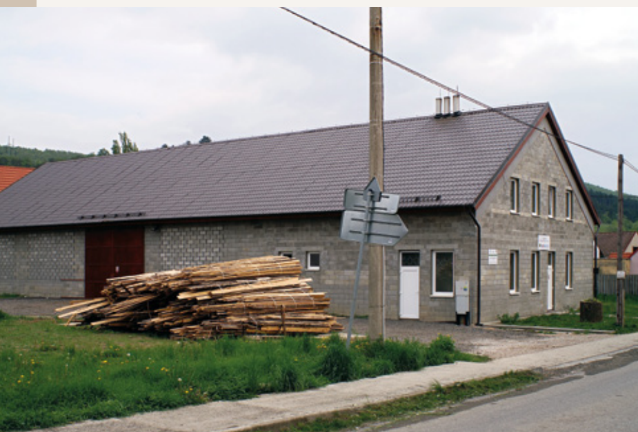
Obecní výtopna na biomasu v Měňanech (foto Cyril Kozák)
